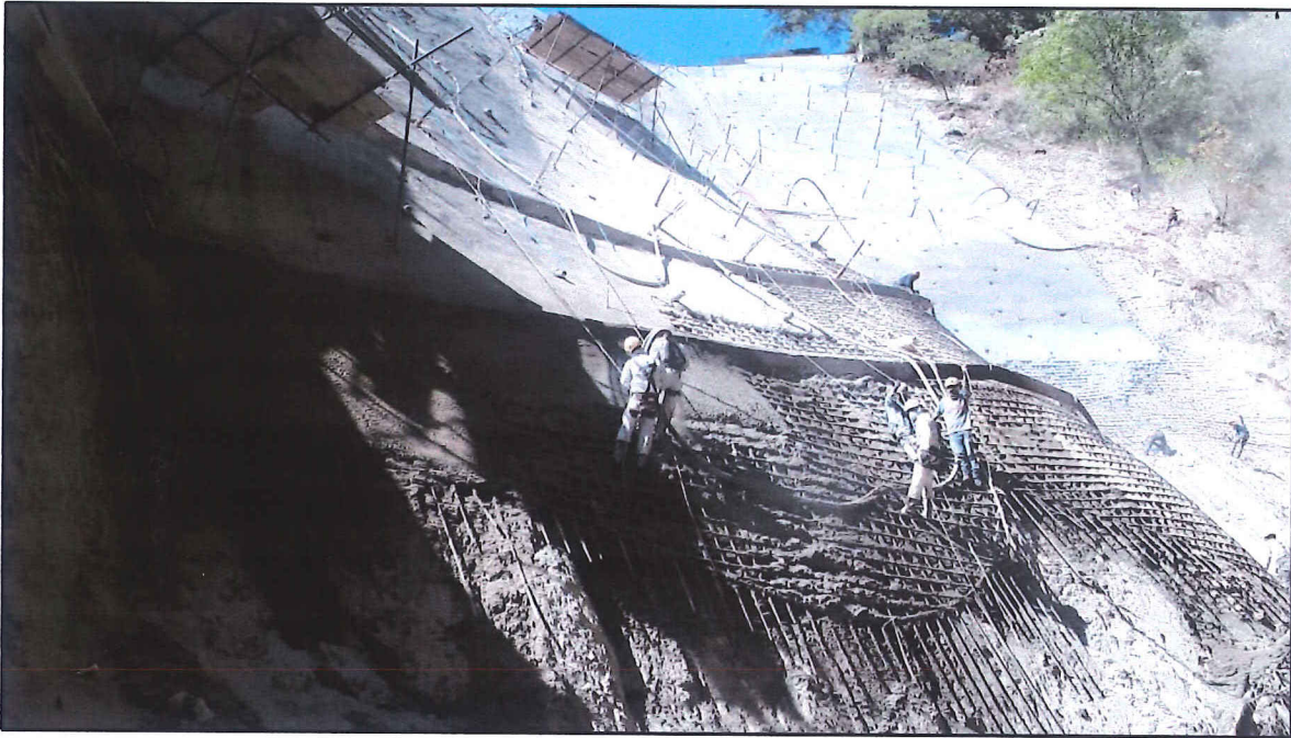
Fotografía 6: Fundición de muro soil nailing
