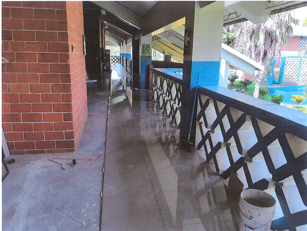
Colocación de piso de porcelanato en Torres de Aulas 1 y 2 existentes.
