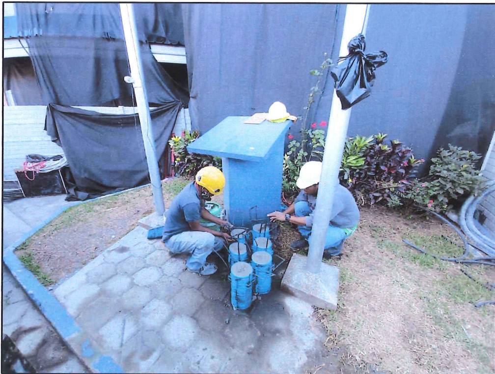
Fotografía 2: Prueba de testigos de concreto
