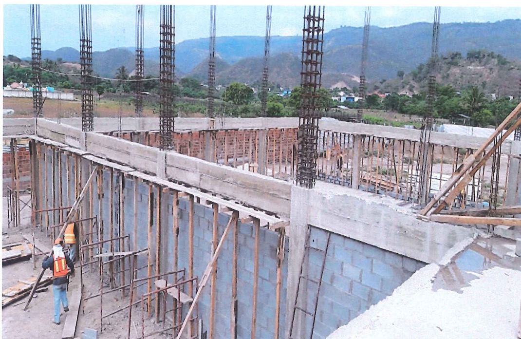
Edificio de Talleres: Taller de Tecnología del Automóvil, desencofrado de viga y levantado de pared.
