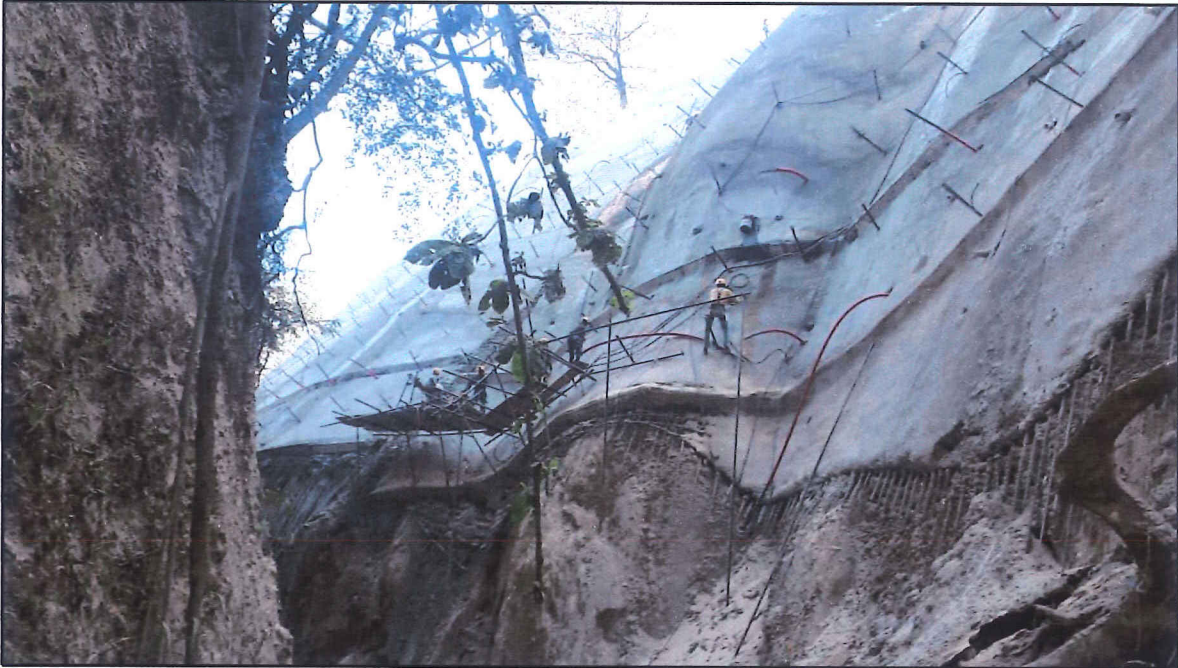
Fotografía 1: Fundición de disipador
