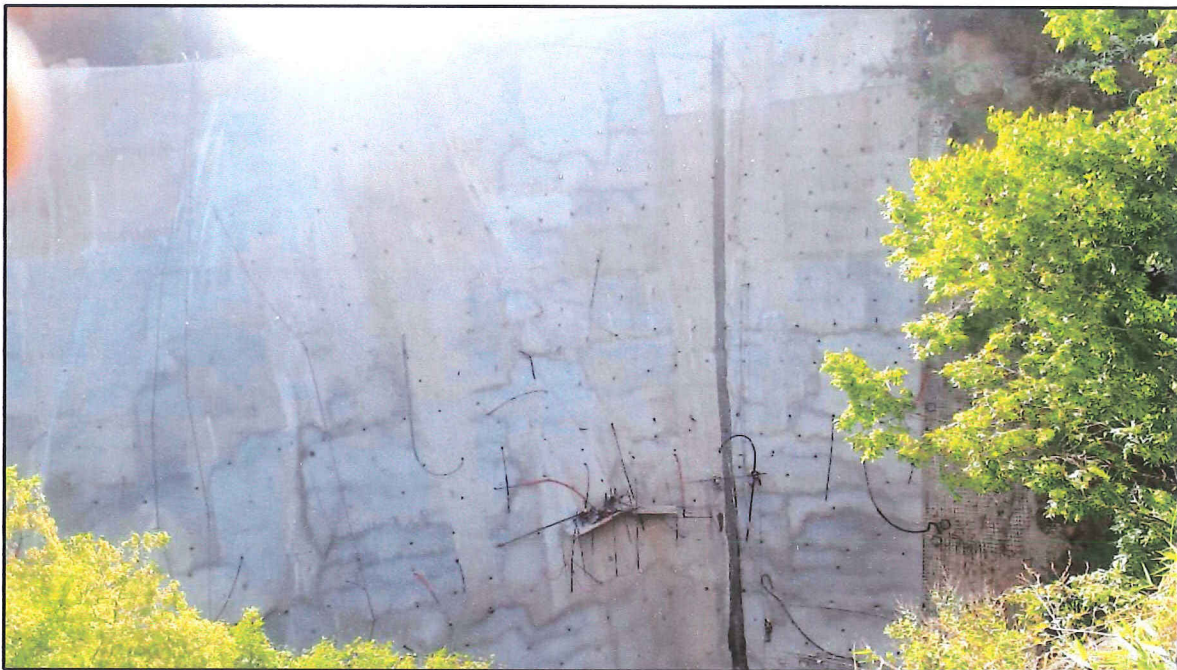
Fotografía 4: Fundición de muro soil nailing
