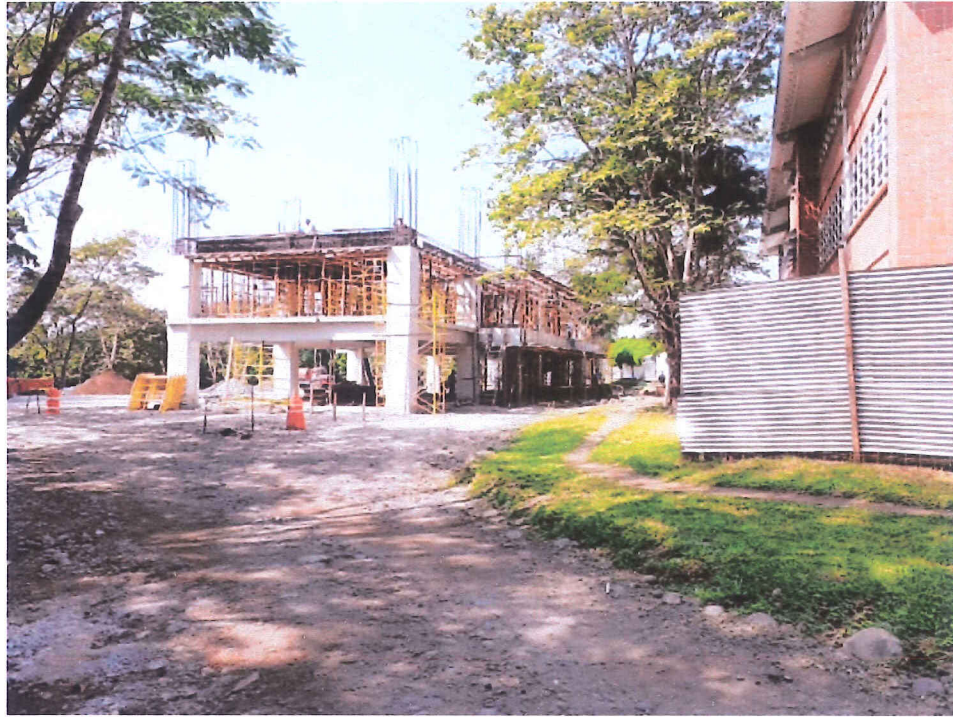
Preparación de tarima y armado del refuerzo de la losa del nivel 2 de la Torre de Aulas 3.
