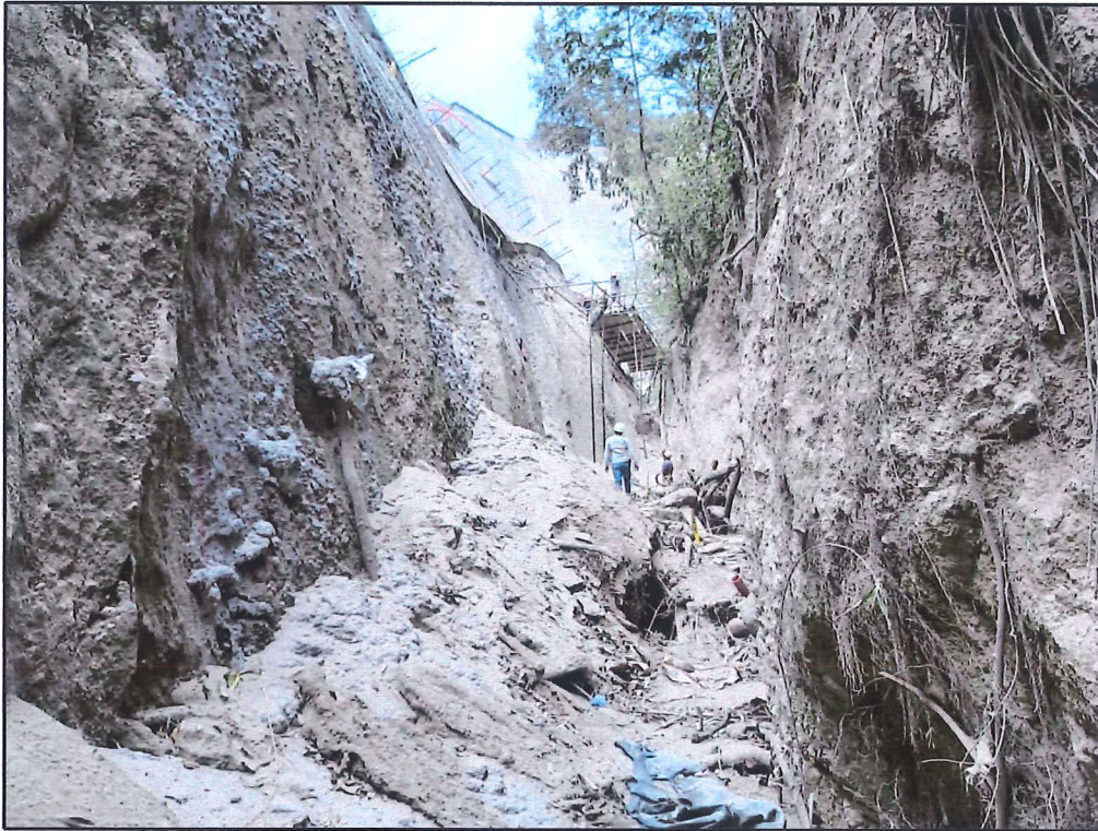
Fotografía 3: Limpieza y retiro de material en cuenca
